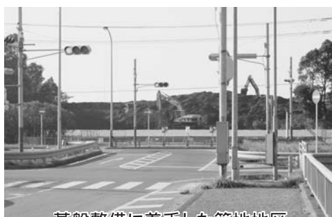
基盤整備に着手した築地地区
