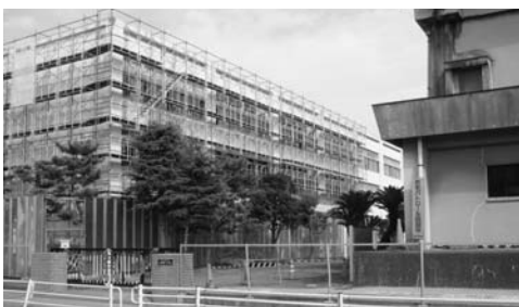
耐震工事が進む木更津第二小学校
