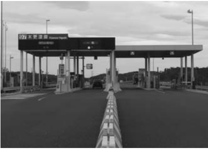
木更津東インターチェンジ
