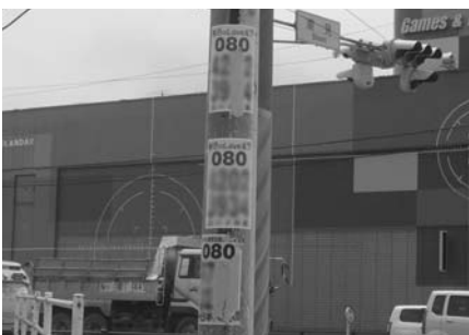
電柱に貼られた違反広告物
