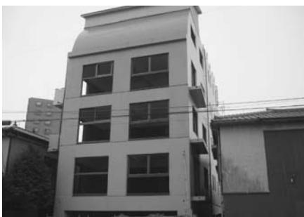
工事中で中断している建築物
