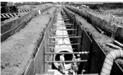
金田地区で進む下水道工事
