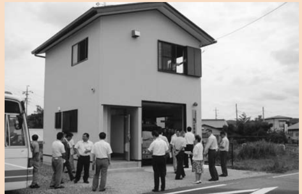
平成21年度事業現地調査(消防団詰所新築事業:富来田地区)
