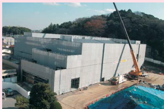
工事中的木更津第三中学校
