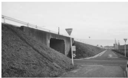
立体交差構造の国道16号(高柳)
