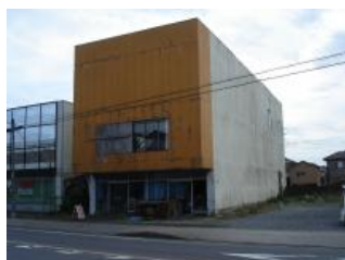
建物正面（国道側）
