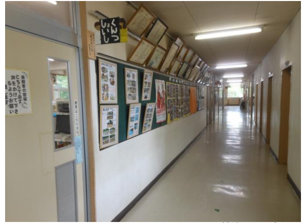
S5 6校舎 1F 廊下
