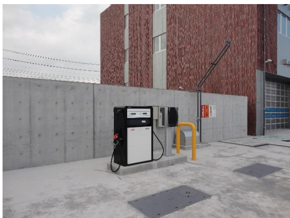
自家給油施設
