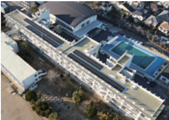
清見台小学校に設置した太陽光パネル
