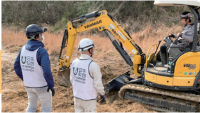
重機訓練の様子
