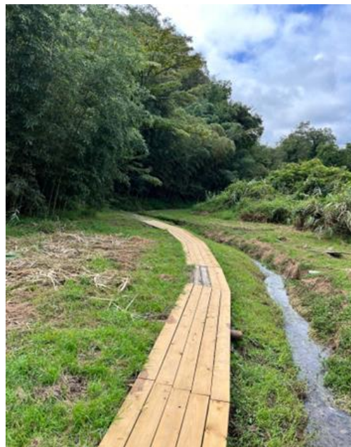
<修繕後の木道の状況>
