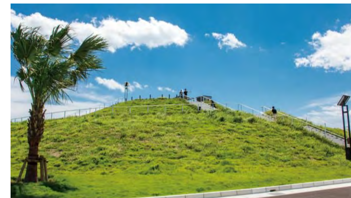
法面イメージ (千葉県旭市 日の出山公園 高さ7m)
