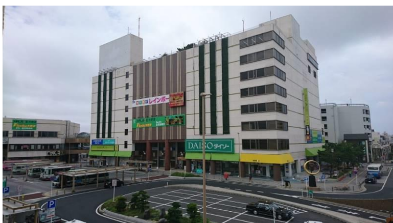
再開発ビルの現状 （中央の9階建《スパークルシティ木更津》及び左側の3階建《アクア木更津B館》）
