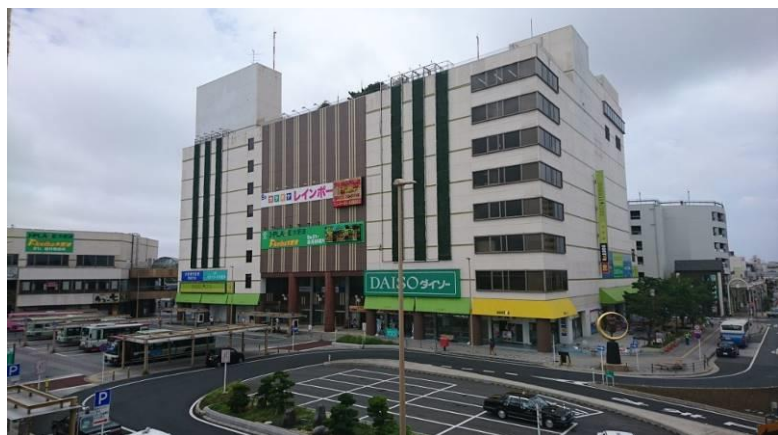
再開発ビルの現状 （中央の9階建《スパークルシティ木更津》及び 左側の3階建《アクア木更津B館》）
