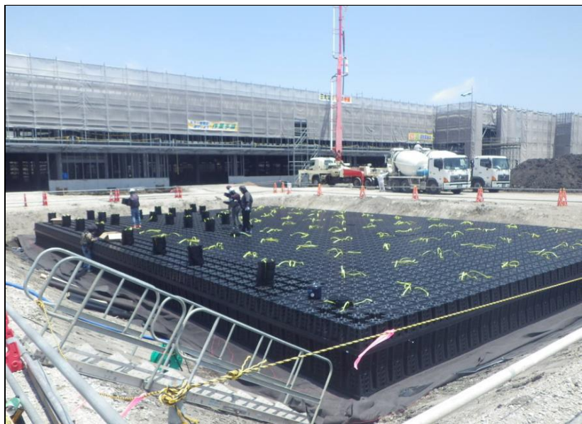
駐車場エリア
