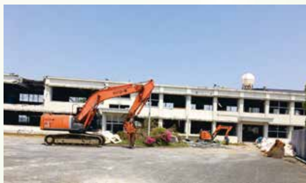
令和2年5月 中郷中学校の解体工事
