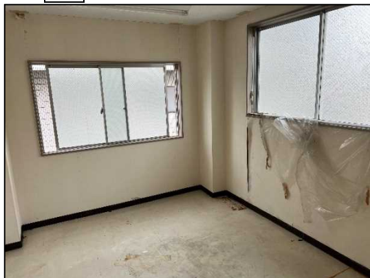
ケ 2階小部屋(倉庫)
