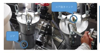
エア抜きコックを開けてエアを抜いて下さい。ヘヤーキャッチャーの脚にあるジグを用い、左図のように三箇所ある U 字の金具を緩め・開けて下さい
