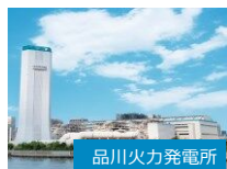
品川火力発電所
