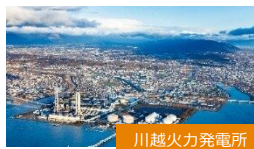
川越火力発電所
