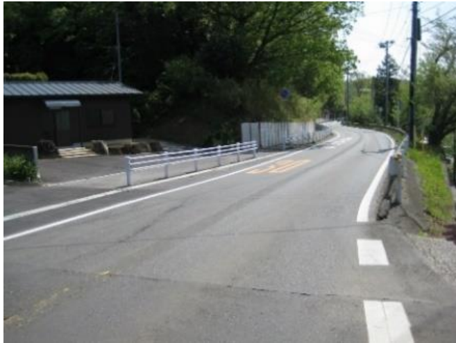
①市道135号線(波岡小学校前)
