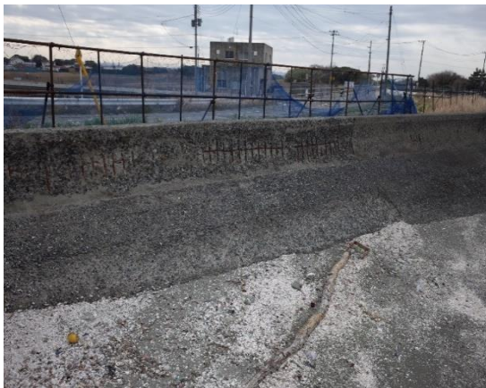
防潮堤の状況
