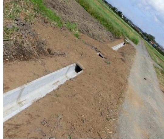
・支線用水路改修完了
