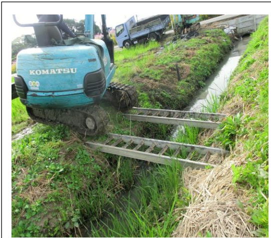
・重機用梯子足場
