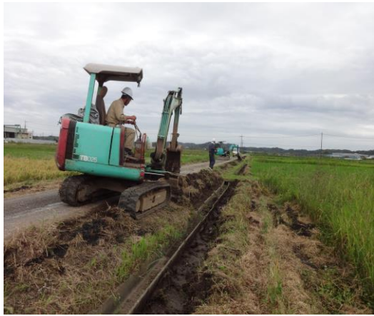
・既存 U 字溝撤去
