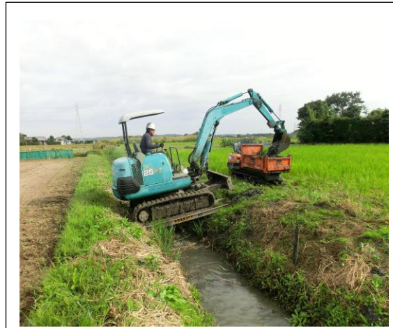
・キャタピラ搬送車に堆積土積み込み
