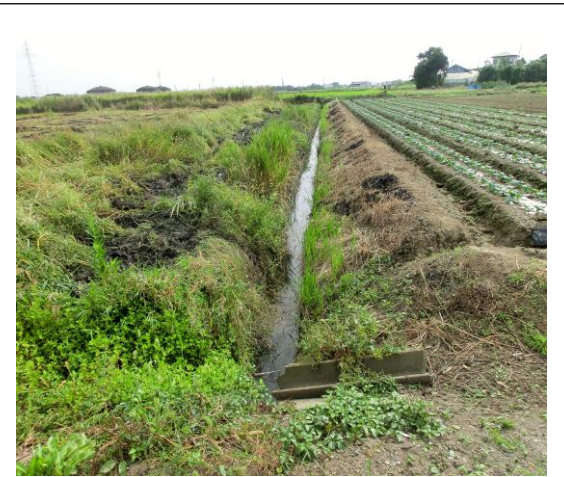
・堆積土撤去後の排水状況
