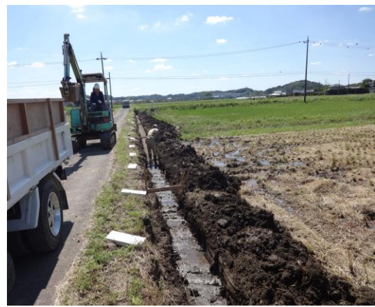
・既存撤去後の路盤整備
