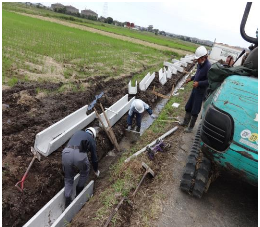
・U字溝敷設 250 幅
