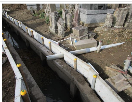
・排水路の土留め作業
