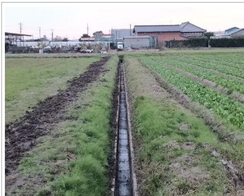
・泥上げ作業完了
