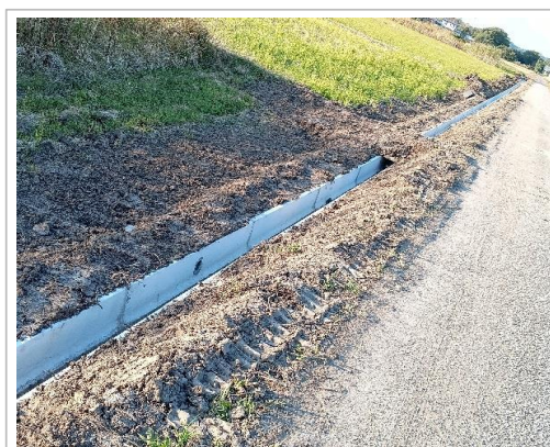
・支線用水路改修完了
