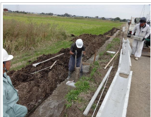
・U字溝敷設 250幅
