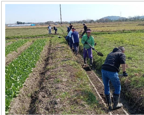
・重機の入らないU字溝部分の人力泥上げ作業
