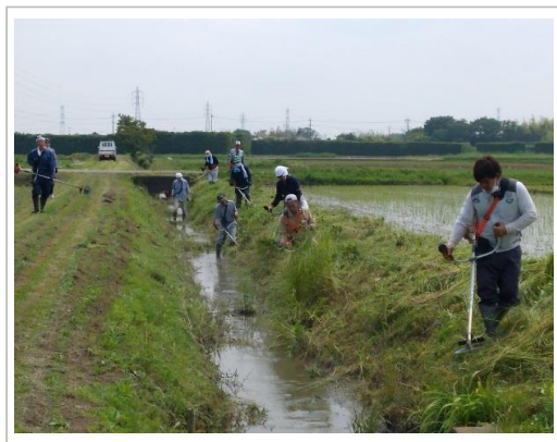
・大排水路の除草作業
