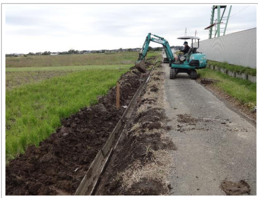
・既存U字溝撤去
