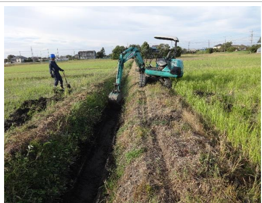
・排水路上部重機による泥上げ
