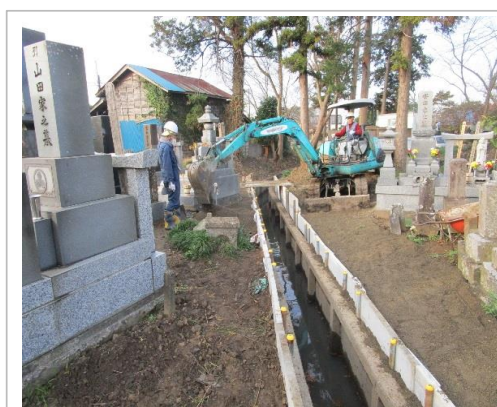
・排水路の土留め作業
