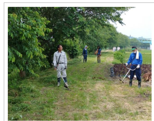
・堤防脇農道の除草
