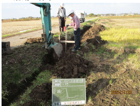
・既存U字溝撤去及び床掘り
