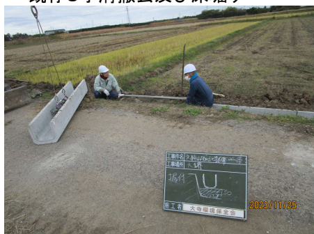
・U字溝据付け
