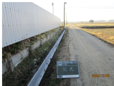
・支線用水路改修完了
