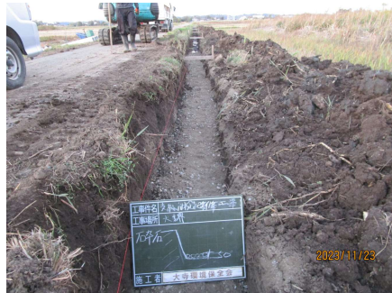
・敷設路盤整備
