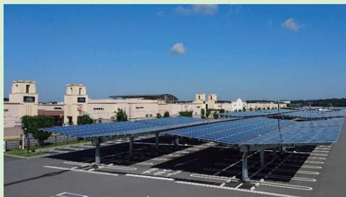
写真 酒々井プレミアム・アウトレットのカーポート型太陽光発電設備
