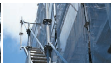
足場仮設工事
