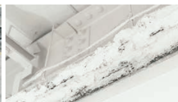
アスベスト工事
