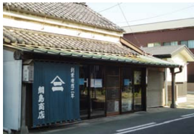
軒先への暖簾の設置
