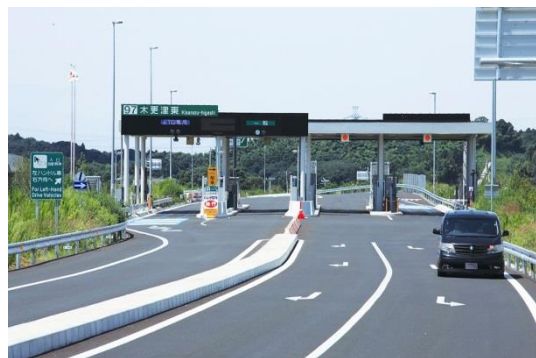
木更津東インターチェンジ
