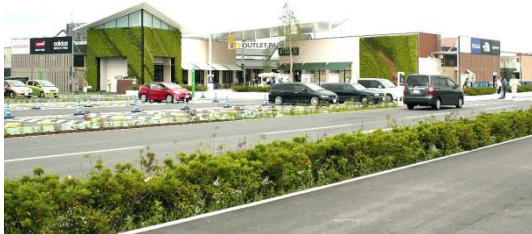
大型集客施設
