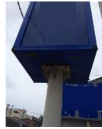
支柱・広告板接合部
