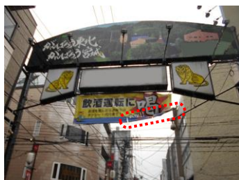
幕材を張る部材が破損した状態
