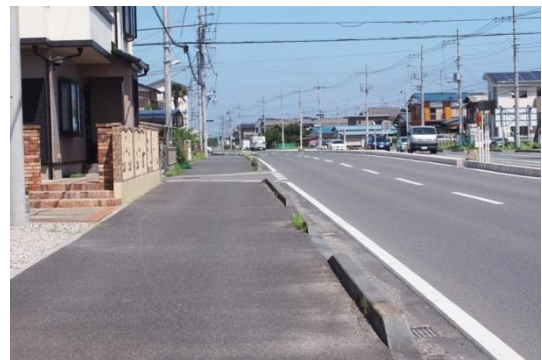
歩道の整備された道路
