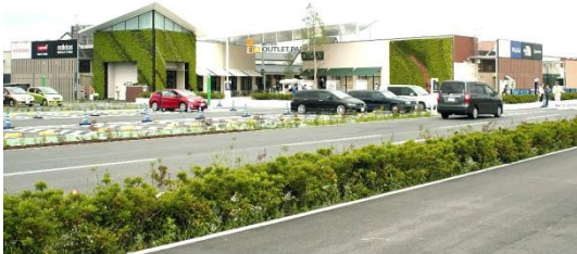
大型集客施設
