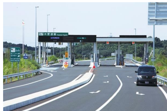
木更津東インターチェンジ
