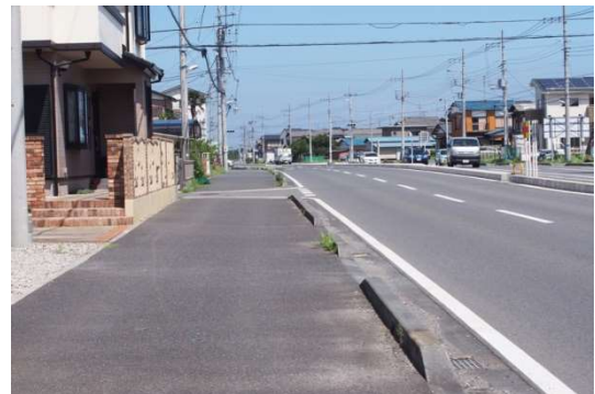
歩道の整備された道路
