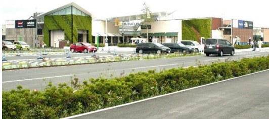
大型集客施設
