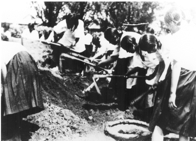
木更津高等女学校生徒の勤労作業(昭和15年)
