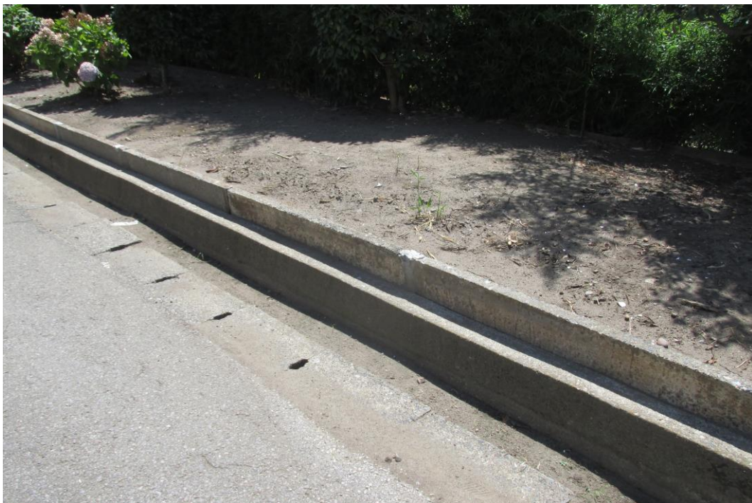
土砂の流出防止のため、従来の土留めの内側にコンクリート板材を埋設した。
