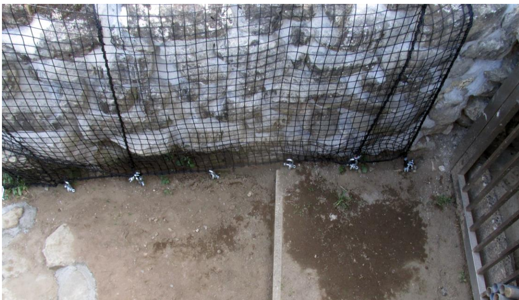
左（西）側の石積み。繊維網で覆い、上、下端をアンカーボルトで固定。
