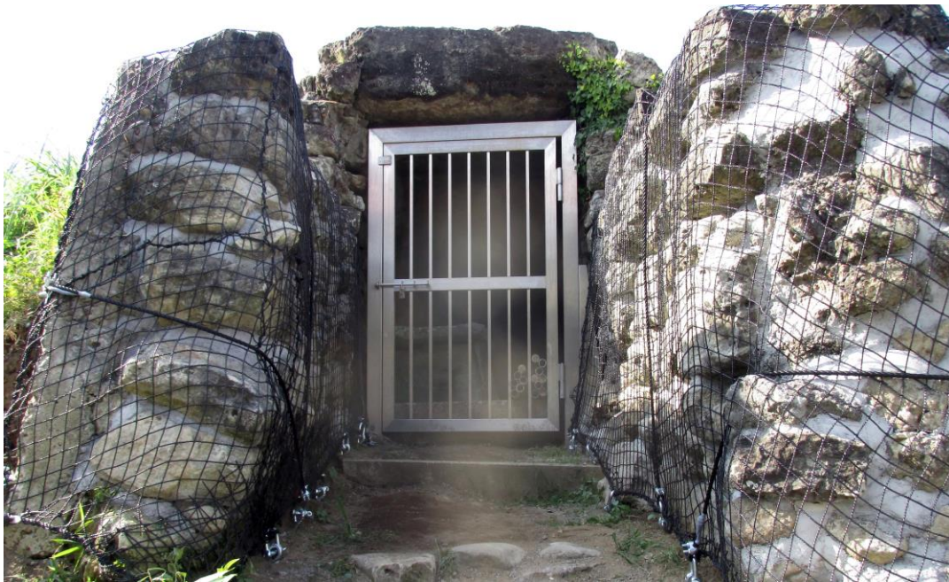
石材の隙間にモルタルを充填、繊維網で覆い、上、下端をアンカーボルトで固定。
