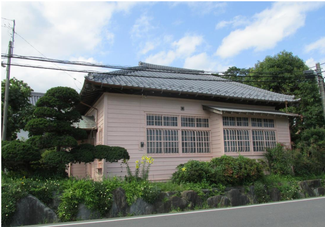
屋根瓦の補修と外壁の再塗装がされ、6月下旬に完了した。
