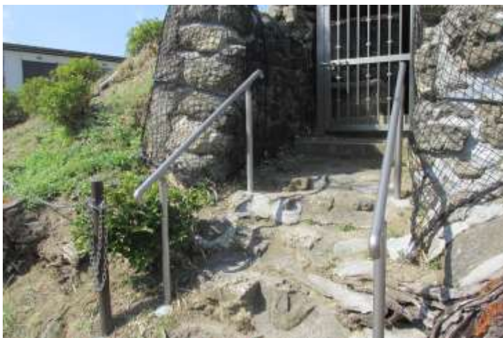
手摺設置工事
