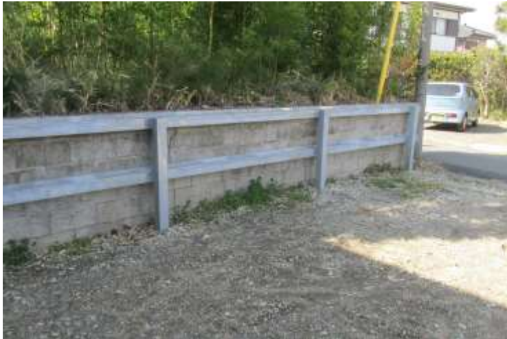
ブロック塀崩落防止工事
