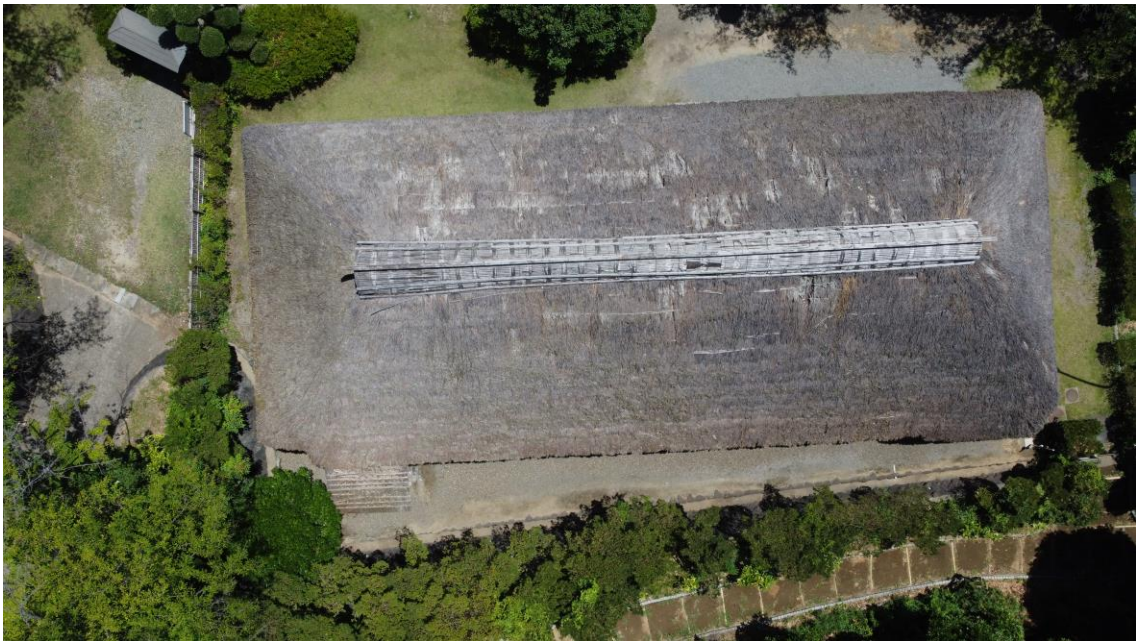
茅葺屋根全体 西側から
