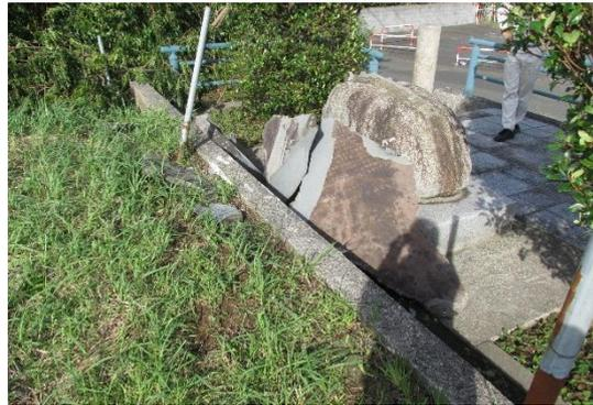
台風15号の強風により、石碑が基部より折損した。
