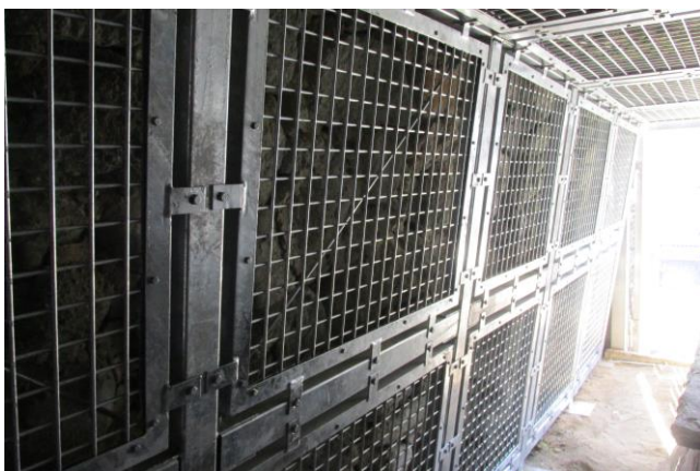
石室東側 金属製ネット設置状況
