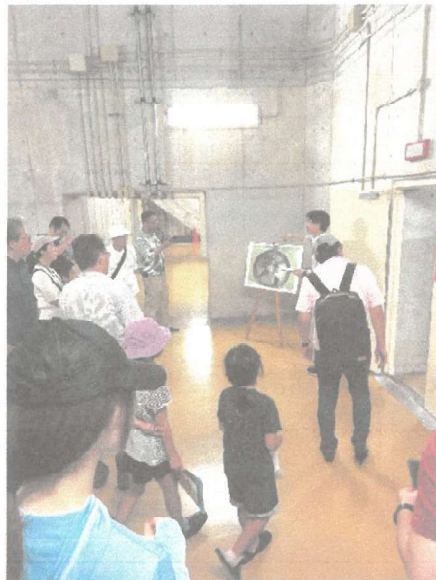
親松排水機場の地下
