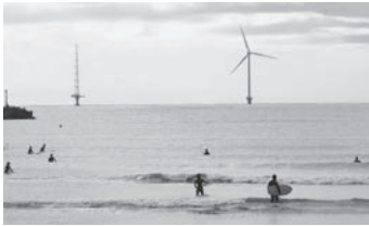
銚子沖洋上風力発電所
