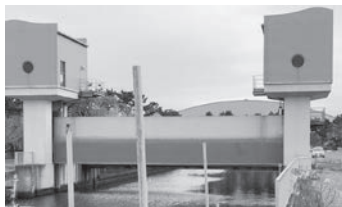
吾妻水門扉体及び開閉装置
