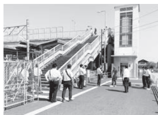
岩根人道跨線橋に設置したエレベーター
