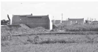
中野畑沢線の浮戸川にかかる橋脚
