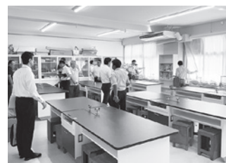
波岡中学校の改修
