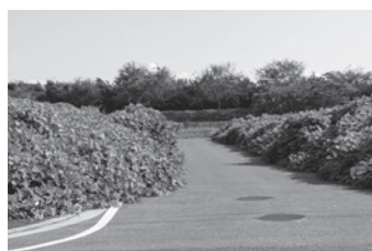
雑草が繁茂している様子
