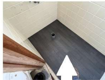
仕上げの床材を更に上から 設置し・・・
