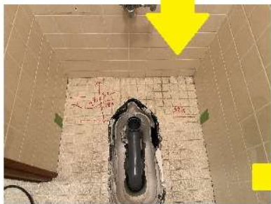
塩ビ管を設置し・・・
