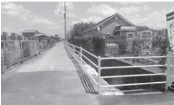
江川区が設置した安全柵
