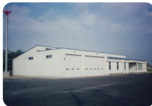
消防署金田分署竣工
