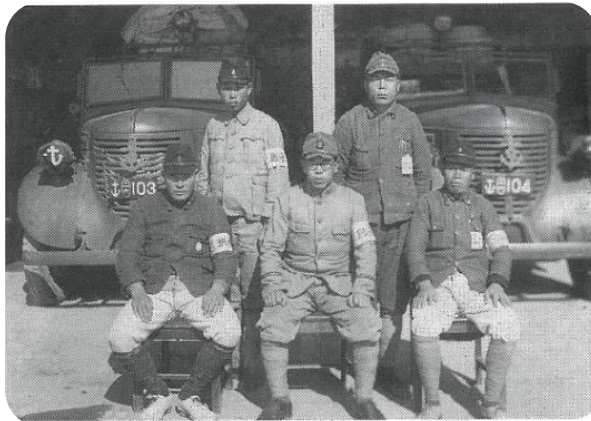
木更津第二航空廠消防詰所前（昭和 20 年）
