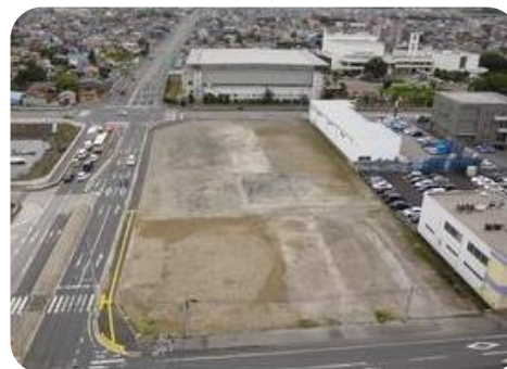
消防本部庁舎建設着工前
