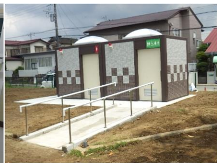
大久保公園トイレ設置工事
