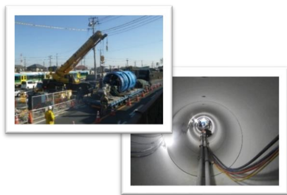
清見台2号雨水幹線 建設工事
