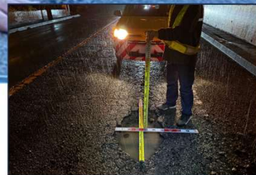
現地にて補修に必要な幅や深さを測量している様子です。
