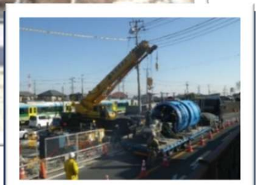
大口径の雨水管を布設している様子です。監督業務が主な仕事です
