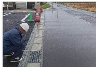
許可物件の完成後、図面通りに施工されているか確認します。
