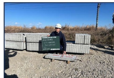
工事を施工するにあたり、適切な材料が使用されているかを確認しています。
